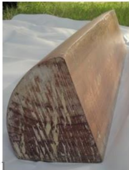
Fig. 3- View of the wooden piece mounted behind the inlet gate شکل ۳- نمای از قطعه چوبی نصب شده در پشت درپچه ورودی
